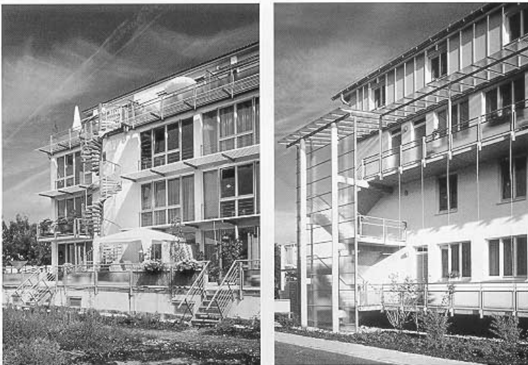
Wohnungsbau im Niedrigenergiestandard in Vaterstetten (Architekt: Claus Steffan; Bildquelle: Dworschak & Wenke 1997)
